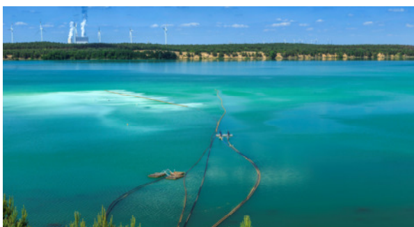
Scheibensee mit GSD-Anlage (seeseitig) im Betrieb
