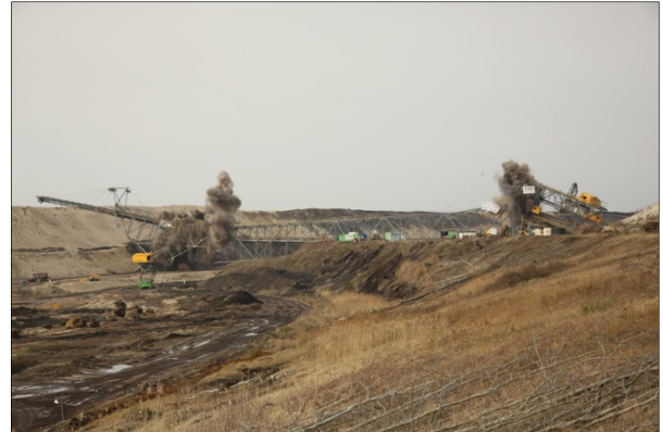
Sprengung der 27 F 34 Förderbrücke am 3. März 2016
