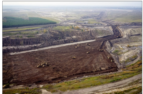
Verfüllung der Kohlebahnansfahrt mit Abtragsmassen der Innenkippe
