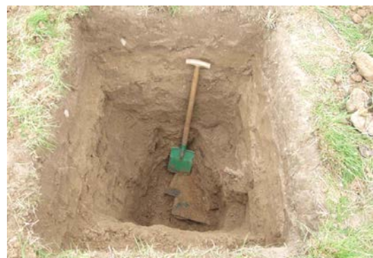
freigelegter Bohrkeller mit abgedeckter Bohrung
