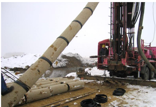
Einbau von Kiesklebefilterrohren bei der Tagebauentwässerung
